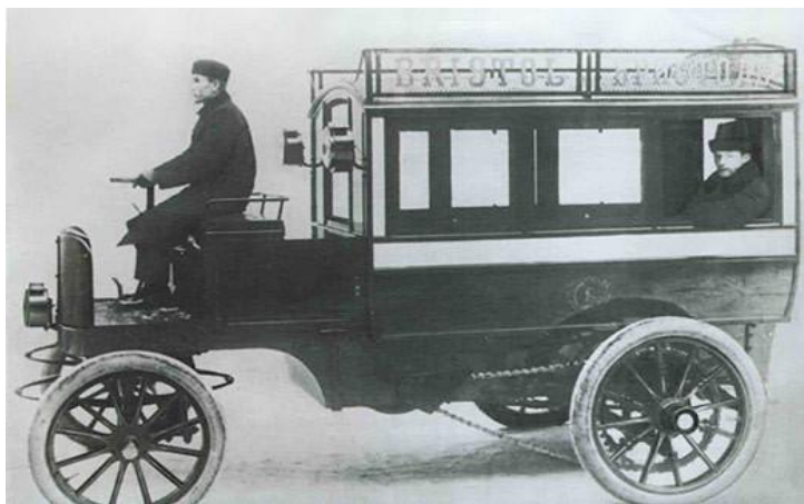
Рис. 6.10. Электрический омнибус «Дукс» Ю. Меллера. Построен в 1901 г. Длина – 4300 мм, ширина – 1900, высота – 2700, база – 2850
