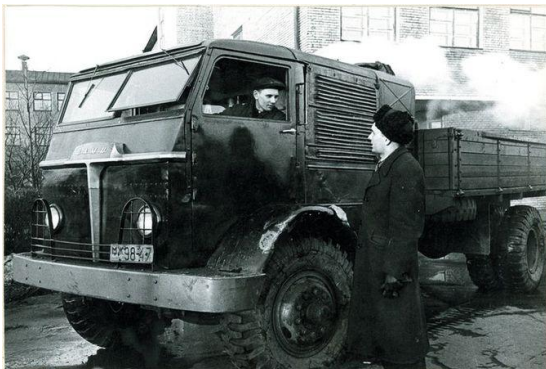
Рис. 5.44. Паровой автомобиль НАМИ-012, работавший на дровах
