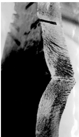
Рис. 6.13. Зона встречи трещин
