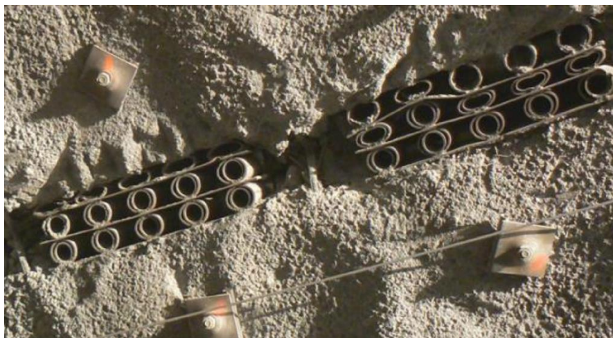
Рисунок 2. Применение WABE элементов для соединения тюбингов [4]
